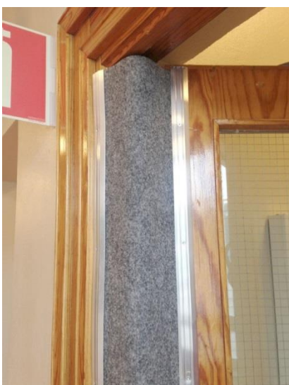
Utanpåliggande klämskydd av filttyg, dyker upp där klämskydd inte tas med från början
