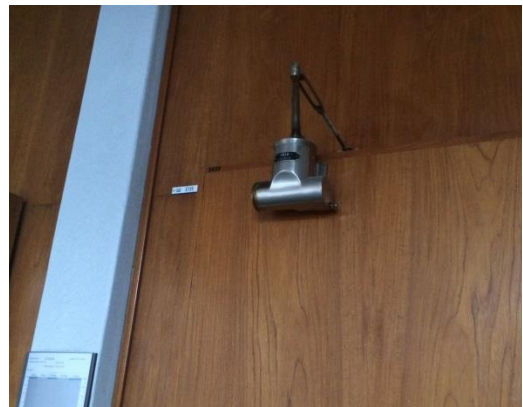
Bild 2. Oljefylld dörrstängare
