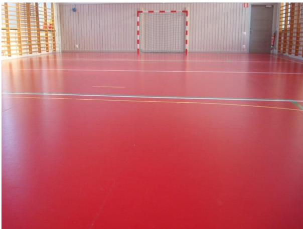
Bild 3: Högalidskola, Punktlastiskt sportgolv med Taraflex Performance 9,0mm sportmatta installerat mot betong
