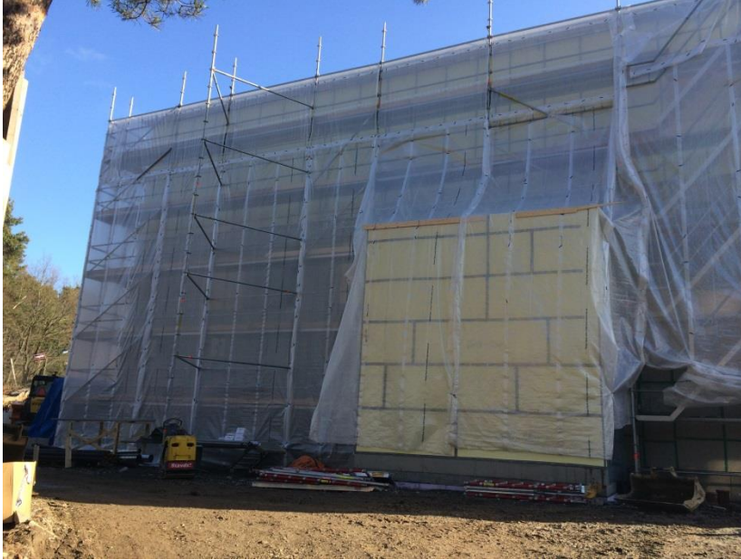
Bild 1. Exempel på heltäckande väderskydd. Byggnaden består av utfackningselement av trä och kräver därför väderskydd i form av tält både ovan tak och runt ytterväggarna.
