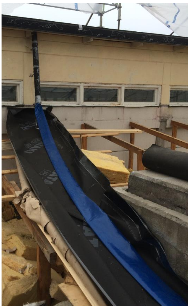
Bild 4. Visar provisorisk takavvattning i samband med ombyggnation
