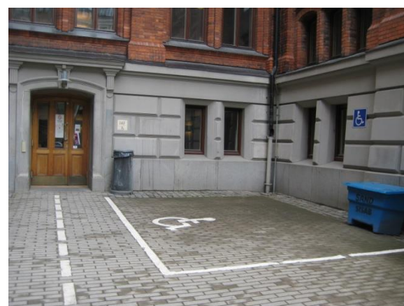
Handikapparkering nära entré, Norra Real
