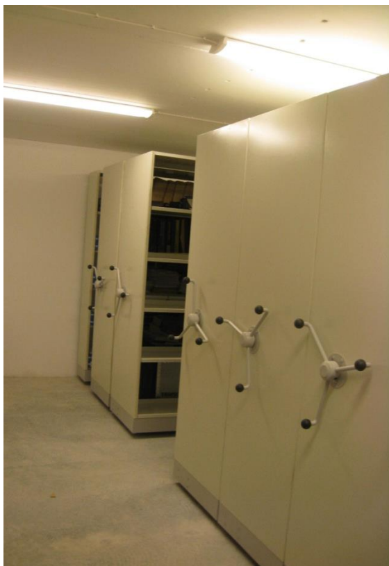
Kompakthyllor med bra belysning(HF-don med kapslingsklass IP 44)
