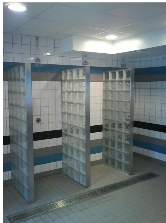
Duschrum på Äppelviken skola med skärmvägg av glasbetong
