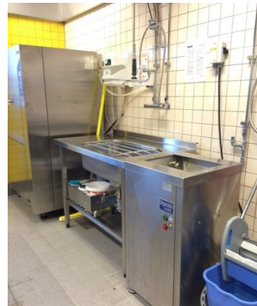
Avfallskvarn i anslutning till diskho med spolslang
