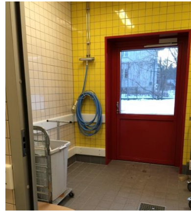
Varumottag med spolslang och golvbrunn
