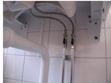
Exempelbild 10. Installation under tvättställ
