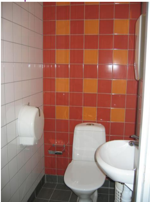
Exempelbild 12. Kontrastmarkering bakom toalettstol.
