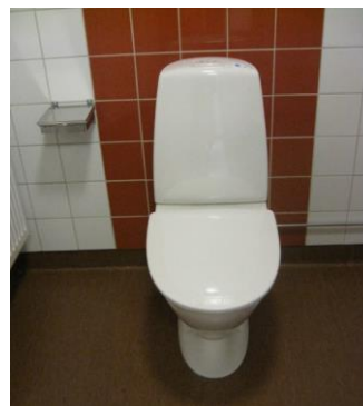
Exempelbild 4. Sanitetspåshållare och kontrastmarkering bakom toalettstolen
