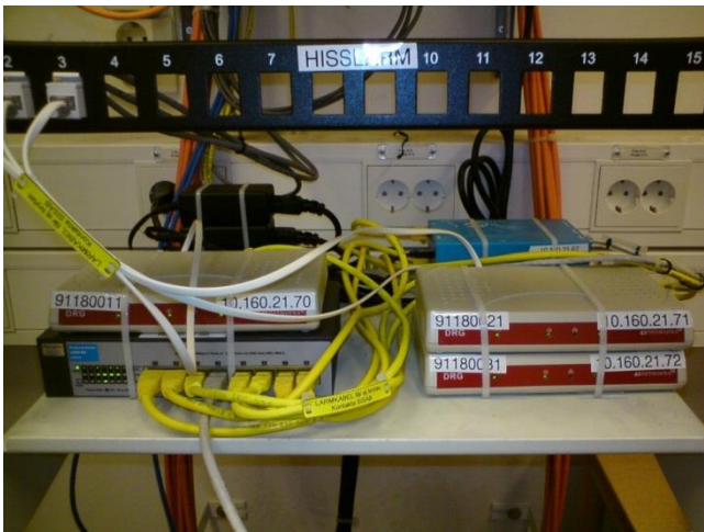
Exempel T-LANswitch och röda hiss-ATAenheter
