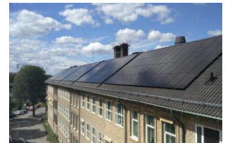
Solceller Thorildsplans gymnasium
