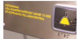
Exempel brailleskrift och text vid nödknapp. OBS Braille i knapp tillräckligt.
