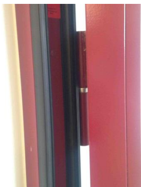
Klämskydd i svart gummi på entrédörr.
