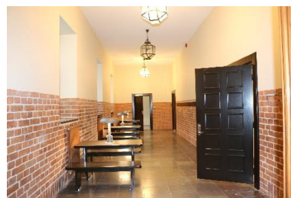
Korridor med akustikputs i tak bibehåller korridorens upplevelsevärden. Östra Real. Foto: Lisa Sundström.
