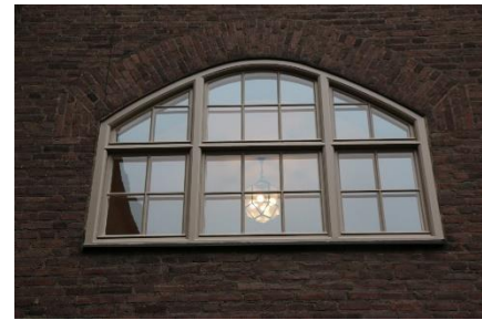
Ursprungliga fönster i Östra Real. Småspröjsade fönster var vanligt vid 1900-talets början. Foto: Lisa Sundström.
