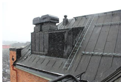
Matteus skola. Anpassa utrustning på taket med hänsyn till byggnadens särdrag. Foto: Lisa Sundström.
