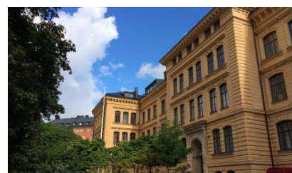
Katarina södra skola på Södermalm uppförd under 1880-talet i nyrenässans. Foto: SISAB.
