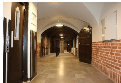
Använda kalkstensgolv är ett värdefullt karaktärsdrag, undvik slipning. Foto: Lisa Sundström.
