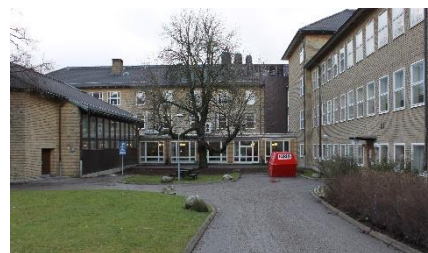
Thorildsplans gymnasium på Kungsholmen uppförd under 1940-talet efter ritningar av arkitekten Paul Hedqvist.
