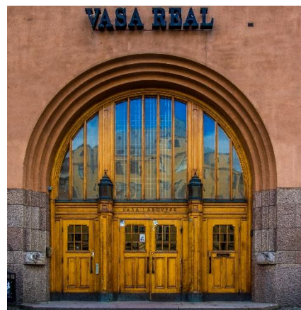
Vasa Reals portal med putsprofiler och natursten i sockeln. Foto: SISAB.
