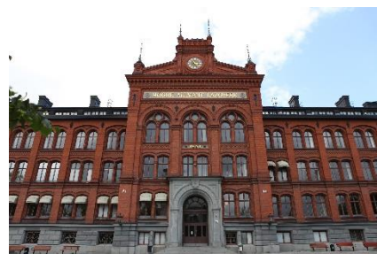
Södra Latin på Södermalm uppförd under 1890-talet i 1800-talet i tegelarkitektur med nygotiska drag. Södra Latin är uppförd efter samma ritningar som Norra Real. Foto: SISAB.
