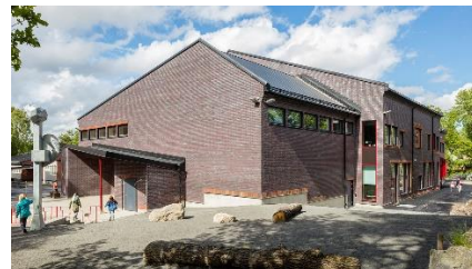
Herrängens skola, nybyggnad. Tovatt Architects and planners.
