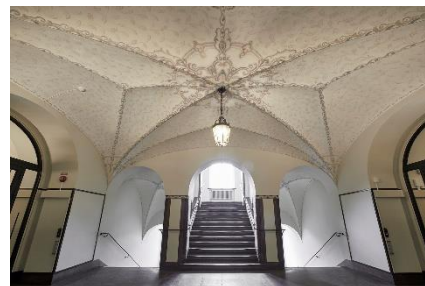
PA Fogelströms gymnasium. Diskret montage av dörröppnare och kortläsare. Foto: Mattias Södermark.
