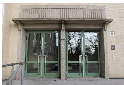
Ursprungliga portar av stål med glasade partier. Nya Elementar. Foto: Lisa Sundström.
