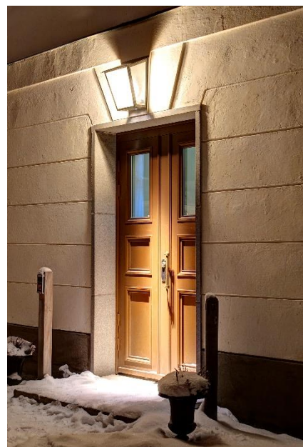
Rosersbergs slott, ny entré med specialritad armatur och kortläsare monterad på stolpe. Foto: Peder Lindbom, AIX Arkitekter.
