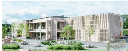
Lustigkulla förskola, nybyggnad, Knivsta kommun. Arkitema Architects.
