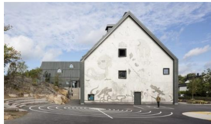
Långbrodalsskolan, nybyggnad. Aperto och NIRAS Arkitekter. Årets Stockholmsbyggnad 2018. Foto: Anders Fredriksen.
