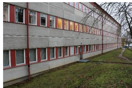
Hjulstaskolan i Hjulsta uppför 1971-72 efter ritningar av Åke Östin Arkitektkontor i modernistisk stil.
