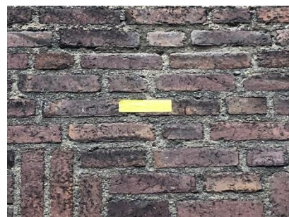
Vid lagning och komplettering av fogbruk ska fog utföras med material och kulör lika befintligt. Foto: Lisa Sundström.
