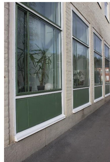
Ursprungliga fönsterpartier i Nya Elementar. Foto: Lisa Sundström.
