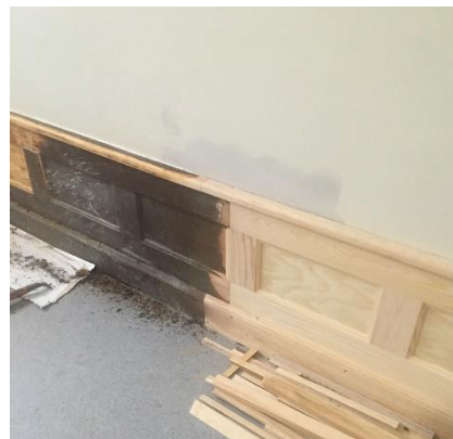
Tidigare ändrade sockelpaneler kompletteras med nya lika ursprungliga. Östra Real. Foto: Lisa Sundström.
