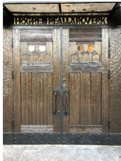
Ursprunglig port med fyllningar och profiler samt draghandtag särskilt utformade för skolbyggnaden. Östra Real. Foto: Lisa Sundström.
