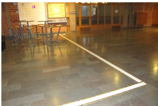
Ledstråk från entré till orienteringstavla i Blackebergs gymnasium. Metallister skall användas till ledstråk. Här har man kompletterat med metallister efter målat ledstråk
