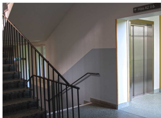
Fruängsskolan. Hissdörr med bra kontrast/omfattning mot omgivningen.
