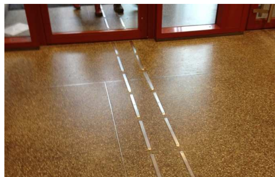
Ledstråk i metall i Lugnets skola. Metallister kan användas till ledstråk då de är hållbara och inte slits ut. Här är listen vald för att passa husets arkitektur.
