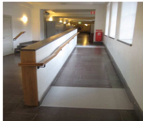
Ramp på Kungsholmens gymnasium, kontrast i avvikande material.
