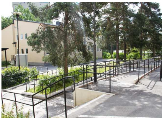
Både trappa och ramp markeras tydligt. Fruängsskolan.
