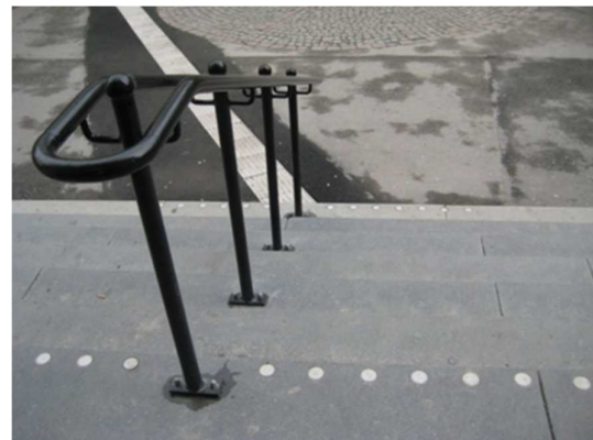
Vita cylindrar infällda i befintliga steg. För glesa cylindrar. Ledstång rör 300 mm på första och sista steg. Norra Real.
