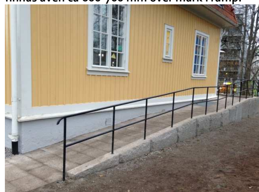
Ramp på Villa Ekbacken
