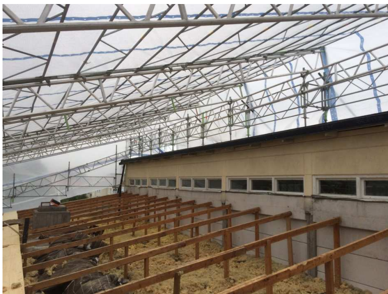
Bild 3. I detta projekt läggs nya ventilationskanaler på vindsbjälklaget vilket kräver ett heltäckande tält för att kunna lyfta av befintligt tak, utföra planerade arbeten samt lägga ny råspont med papp och plåt.
