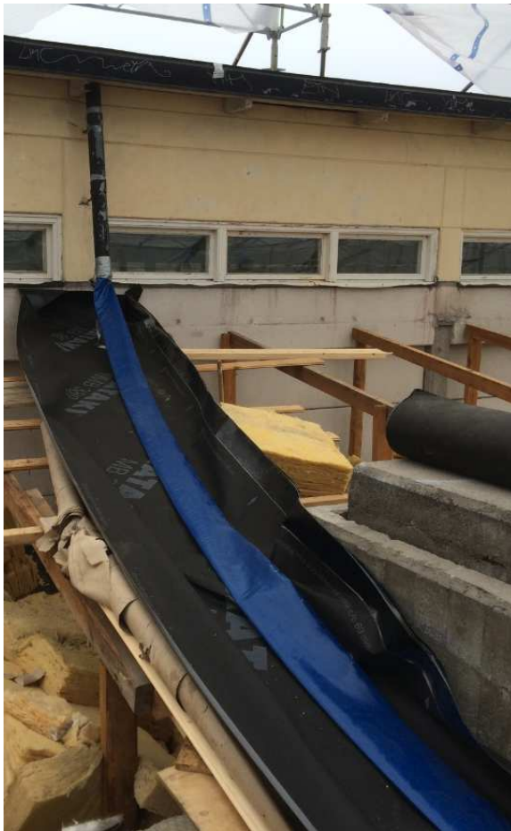
Bild 4. Visar provisorisk takavvattning i samband med ombyggnation
