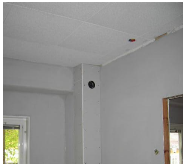
Bild 7, 8 och 9: Fördelningskanal där vertikalt spirorör till undertak ska anslutas.
