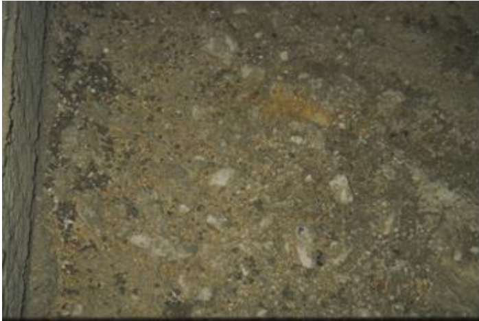
Bild 1 Det gula är sågspån på betongplatta
