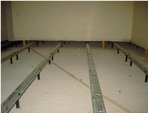
Bild 10 Regelsystem av förzinkat plåt
