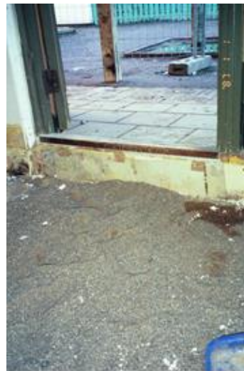
Bild 4 Yttervägg under marknivå
