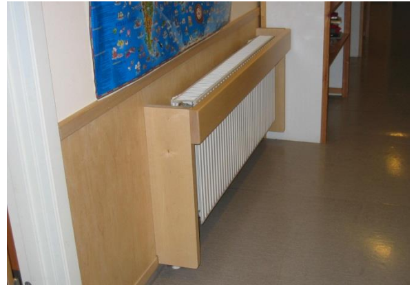
Radiatorskydd enligt referensritning A3, Laxholmsbacken 1
