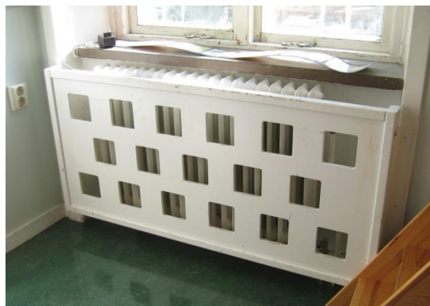
Radiatorskydd heltäckande, klättringsrisk bör beaktas. Möckelvägen 31
