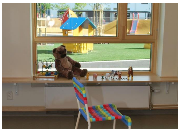
Fönsterbänk som har gjorts som hylla längs hela väggen, binder samman två fönster, Temmelburken
