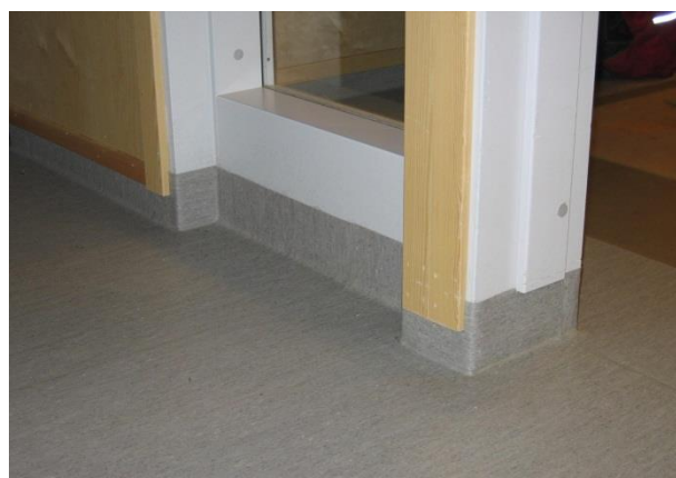
Bröstningspanel och uppvikt plastmatta, enligt referensritning A6, obs med denna lösning uppfylls inga akustiska krav mellan rum
