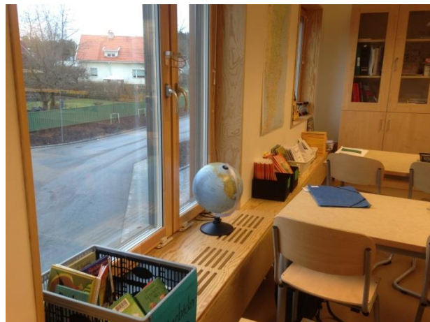
Kombination av bröstningspanel och sockel som bildar fönsterbänk/radiatorskydd. Ersätter inte uppvikt plastmatta. Ursviksskolan
