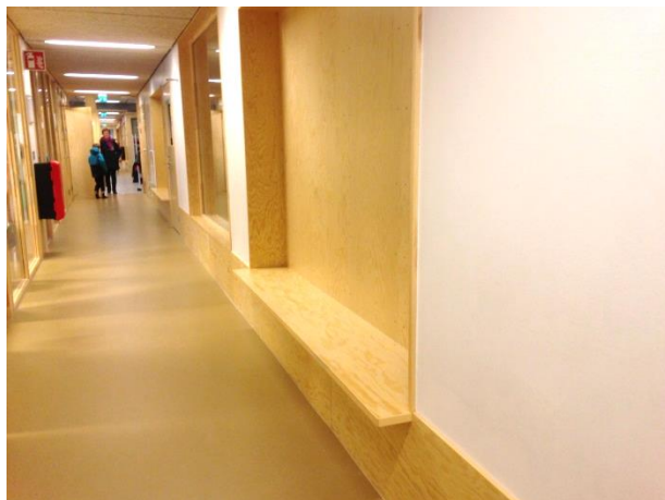
Kombination av bröstningspanel och sockel som integreras i fast möblering. OBS ev brandkrav. Ersätter inte uppvikt plastmatta. Ursviksskolan
