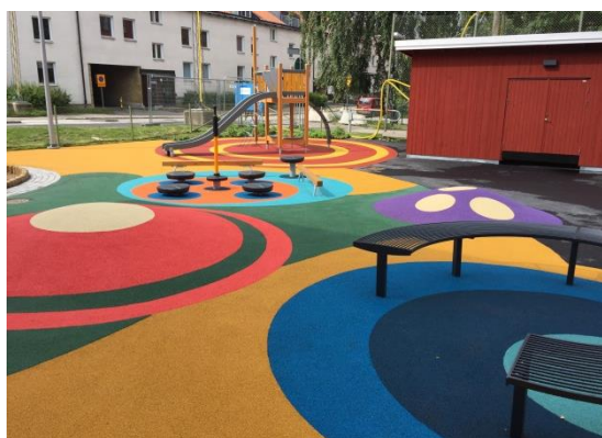
Fallskyddsgummi med färg, mönster och kullar, Örbyskolan
