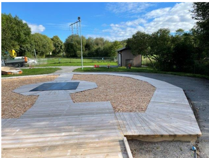
Träflisyta med sarg, Drottningholmsvägen 510
