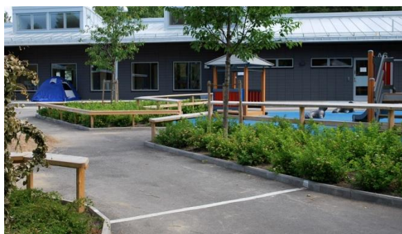
Permanent planteringsskydd i trä, Trollesundsvägen 55
