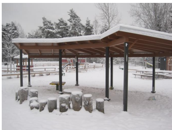
Skärmtak över sandlåda, Trollesundsvägen 55
