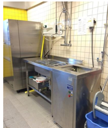
Avfallskvarn i anslutning till diskho med spolslang
