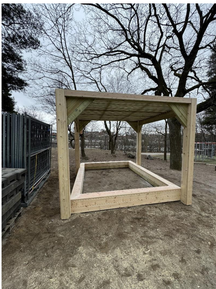
Bild 1: Hela konstruktionens stomme, stolpar samt tak är byggt i tryckimpregnerat trä. Därefter har sittytan samt stolpar klätts med annat virke.
