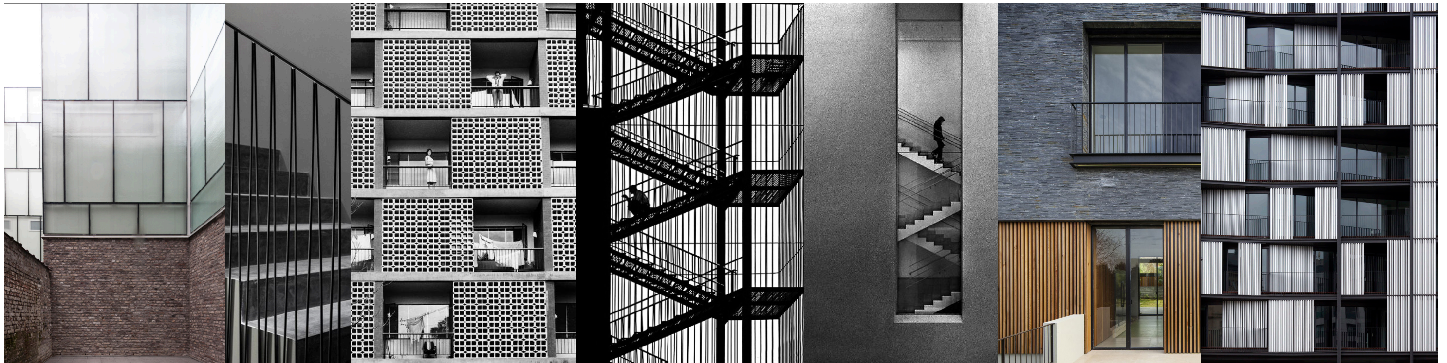
Sockelvåning markeras med avvikande material.
