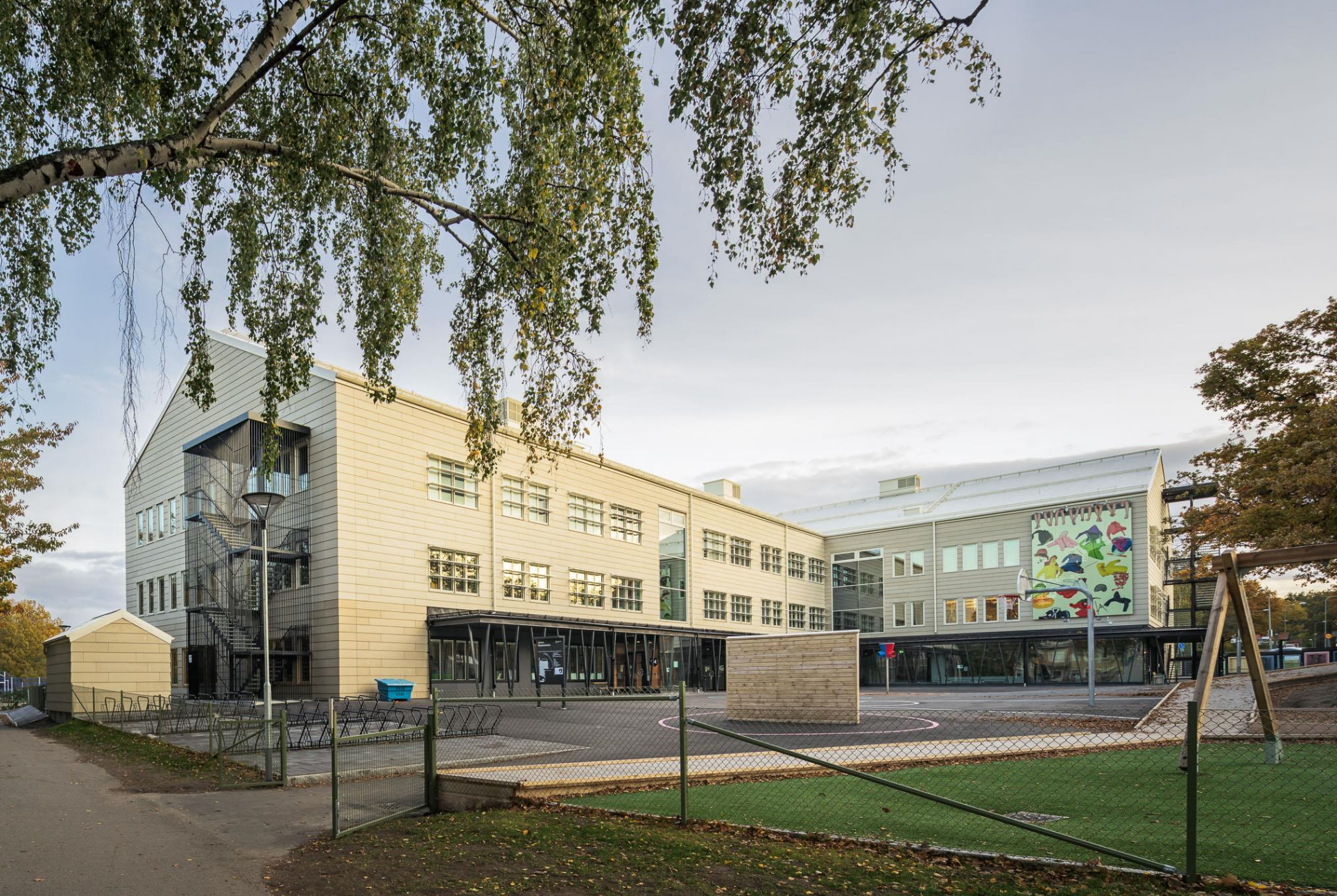
Den L-formade skolbyggnaden med den skyddade skolgården. På den högra fasaden sitter ett konstverk av Maria Friberg och Stockholm Konst, inspirerat av byggnadens gestaltningsidé och utfört i samarbete med skolans elever.
