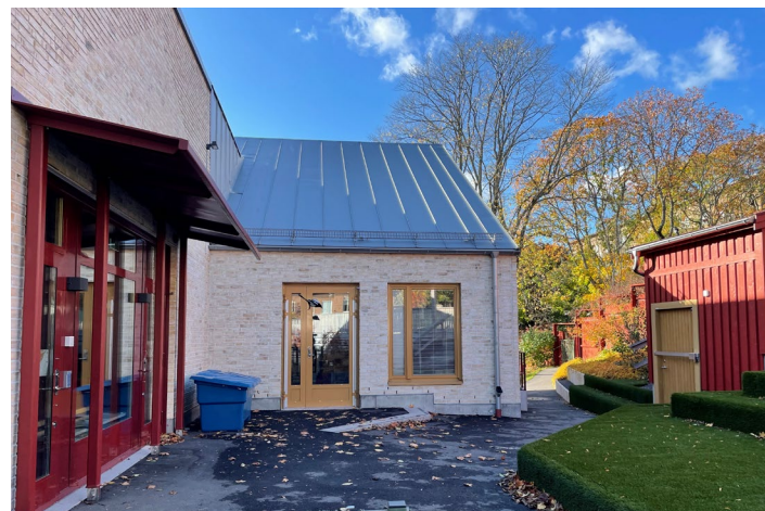
Fasad mot norr med entré från gården
