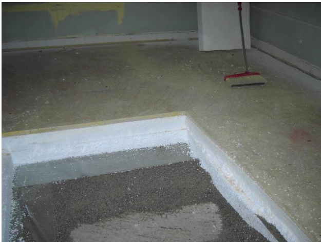
Bild 1 Ursprunglig golvkonstruktion
