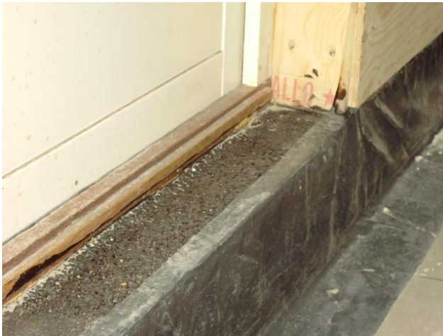
Bild 3 Lättklinkerblock med tätning (lufttätning).
