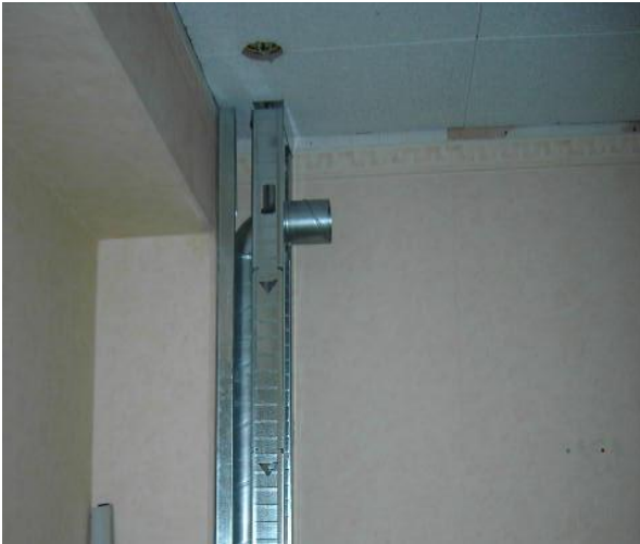
Bild 6 Vertikal tilluftskanal
