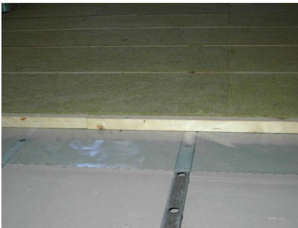
Bild 9 Träregel fästes med långa skruv.
