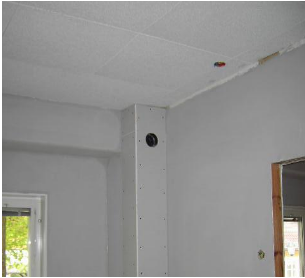
Bild 10 Inklädd tilluftskanal
