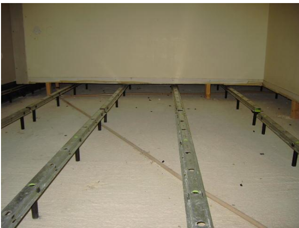
Bild 7 Regelsystem av förzinkat plåt.
