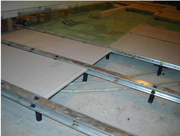
Bild 8 Oorganisk skiva mellan stålregelstomme.
