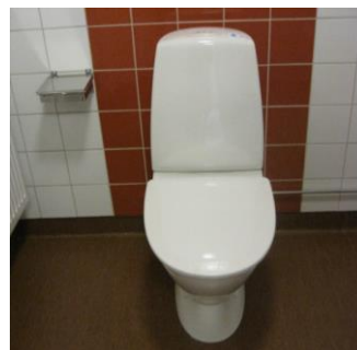
Exempelbild 4. Sanitetspåshållare och kontrastmarkering bakom toalettstolen
